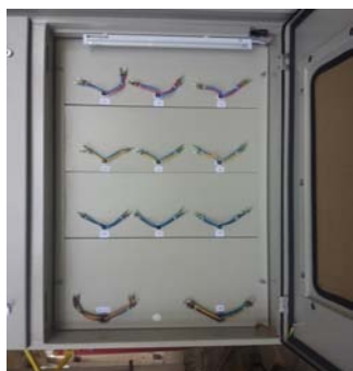
شکل (۶): نمای صفحه نگهدارنده کنتورها
