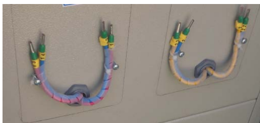
شکل (۵): محل و نحوه خروج سیمها از صفحه نگهدارنده
